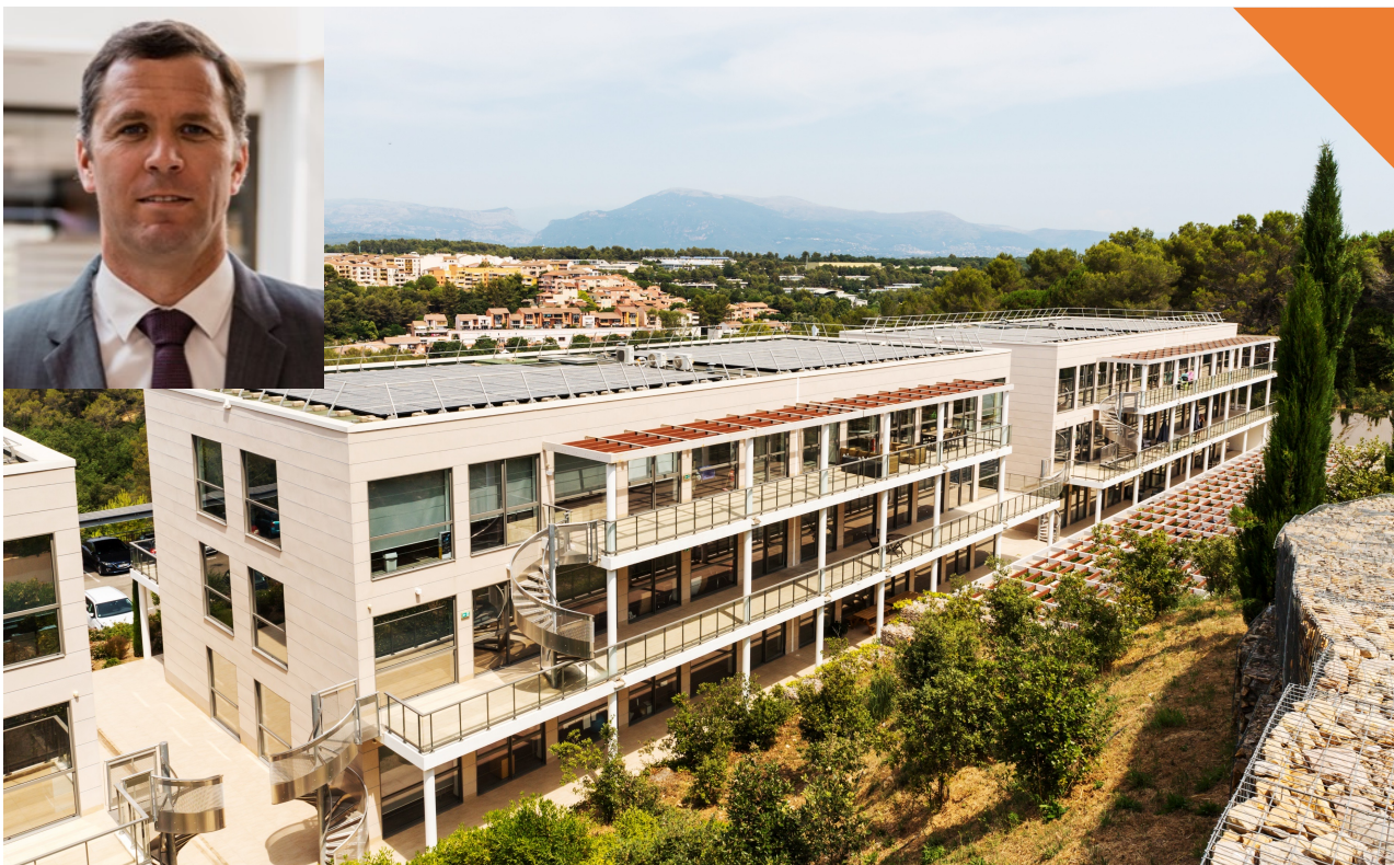
LES AQUEDUCS – Sophia Antipolis – Bureaux, année de livraison 2015 – Bâtiments en autoconsommation
